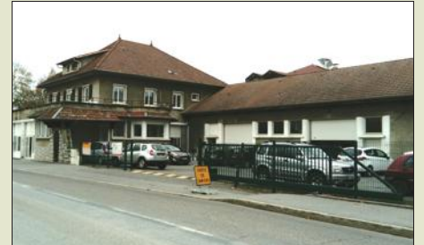
Les locaux de la future unité locale de la Croix-Rouge La Roche-Reignier. Photo Le DL/M.I.
